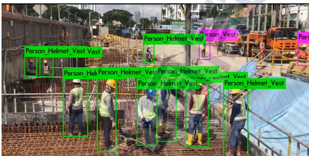
图 58 智慧工地个人防护装备智能检测
